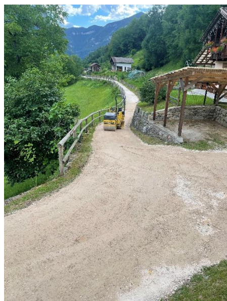
Strada delle Marine
