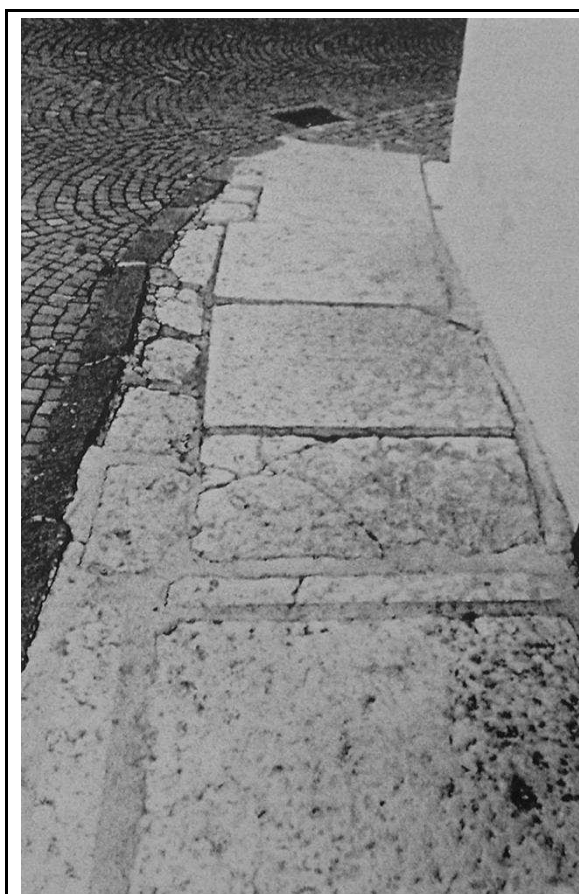
pavimentazione esterna in lastre di pietra
